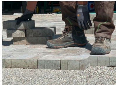
Splitt-Verlegung
